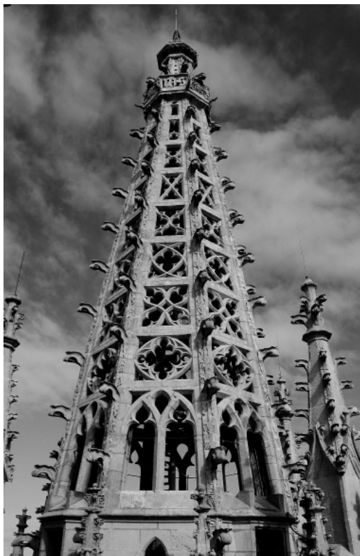
Fig. 3. Vista de la aguja de la torre norte de la catedral de Burgos
