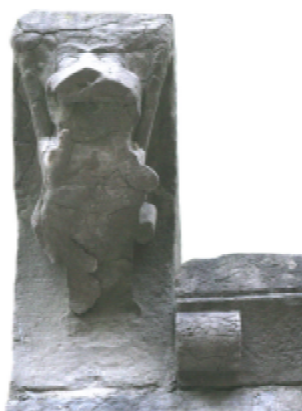
Fig. 36.- Canecillo nº 5. Cámara de Comptos de Pamplona.
