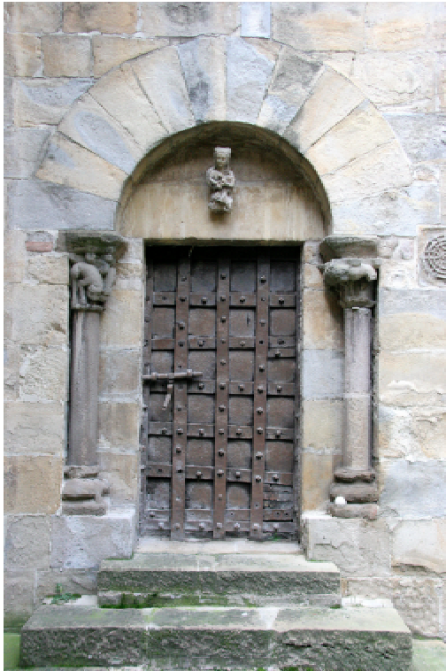
Fig. 12.- Portadita reconstruida con capiteles, columnas y basas de San Nicolás. Patio de la Cámara de Comptos de Pamplona.
