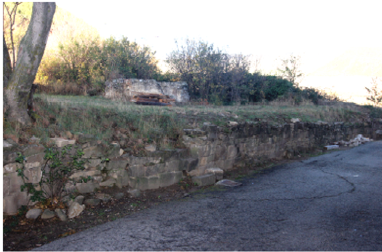
Fig 3.- Murete de contención con piezas reutilizadas
