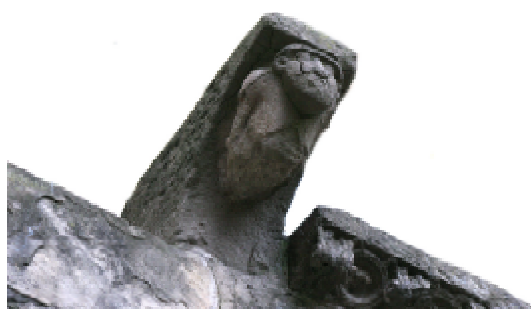
Fig. 34.- Canecillo nº 3. Cámara de Comptos de Pamplona
