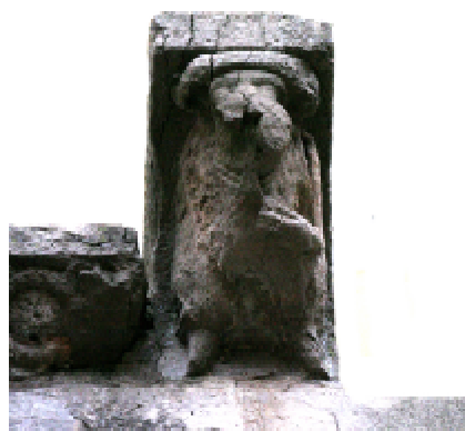
Fig. 35.- Canecillo nº 4. Cámara de Comptos de Pamplona.
