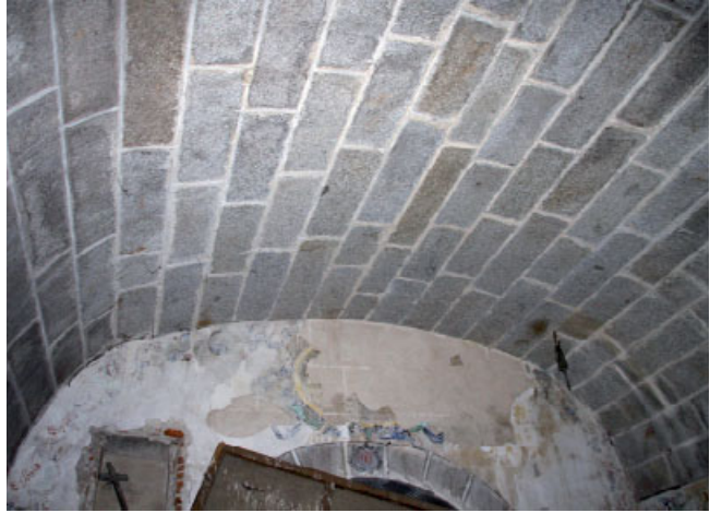
Bóveda del cuerpo bajo de la torre
