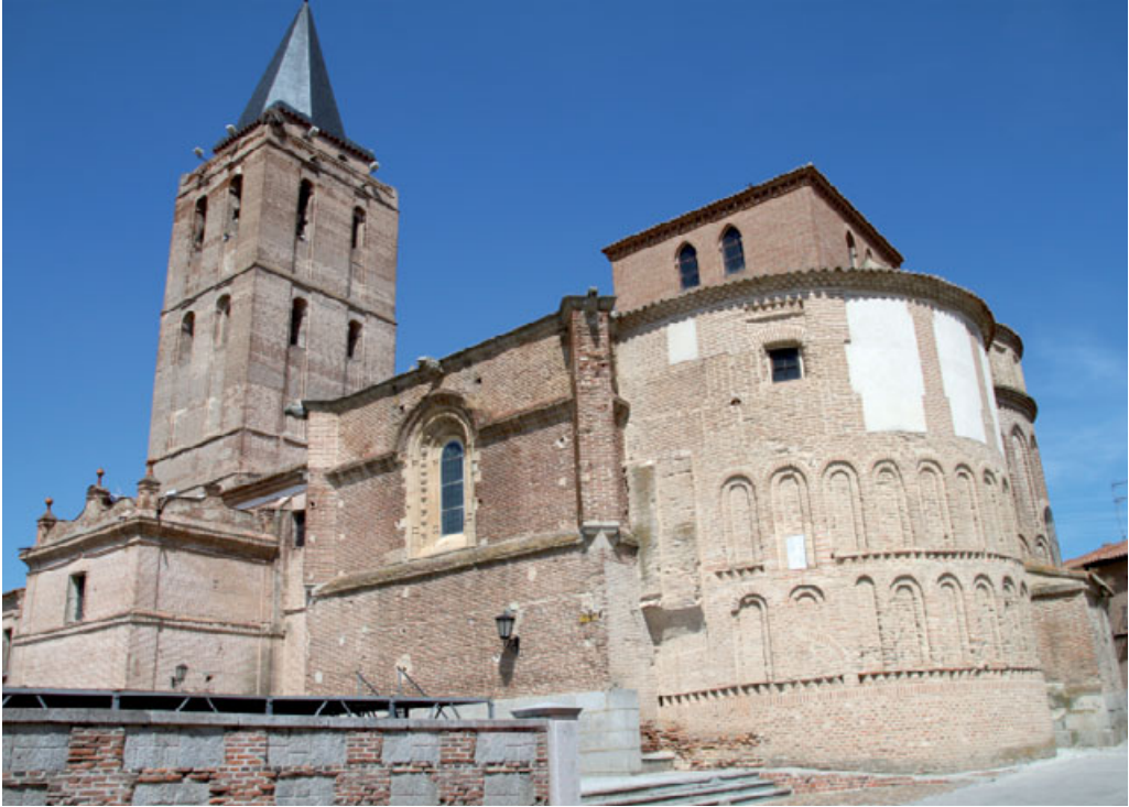
Exterior desde sureste
