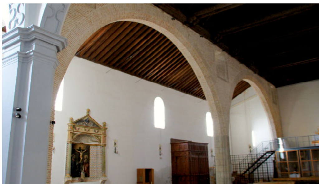
Formeros de la nave meridional
