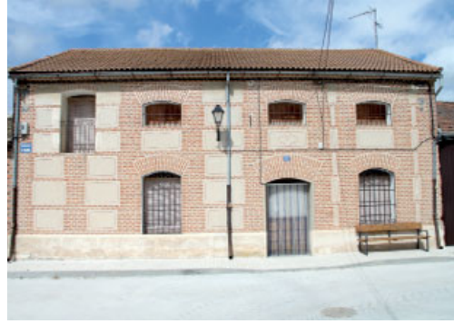
Pajares de Adaja. Casa fechada en 1903 por un letrero sobre la puerta
