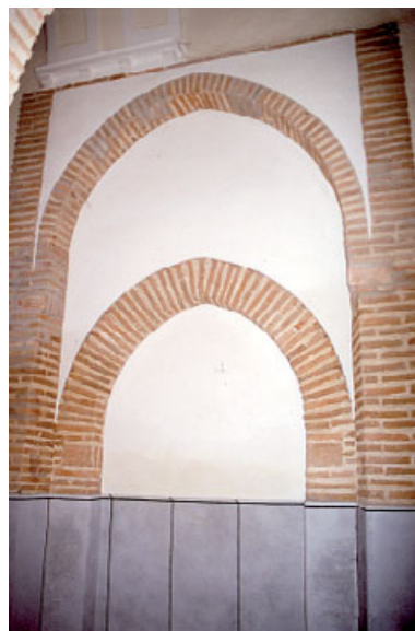
Blasconuño de Matababras. Interior de puerta septentrional cegada
