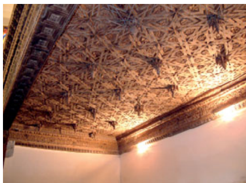
Cantiveros. Sotocoro con armadura de lazo y pinjantes
