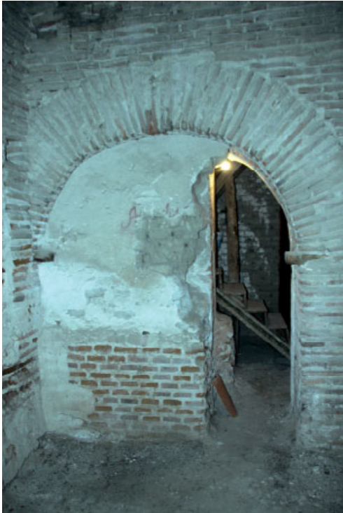
Arco rebajado hacia los pies del templo
