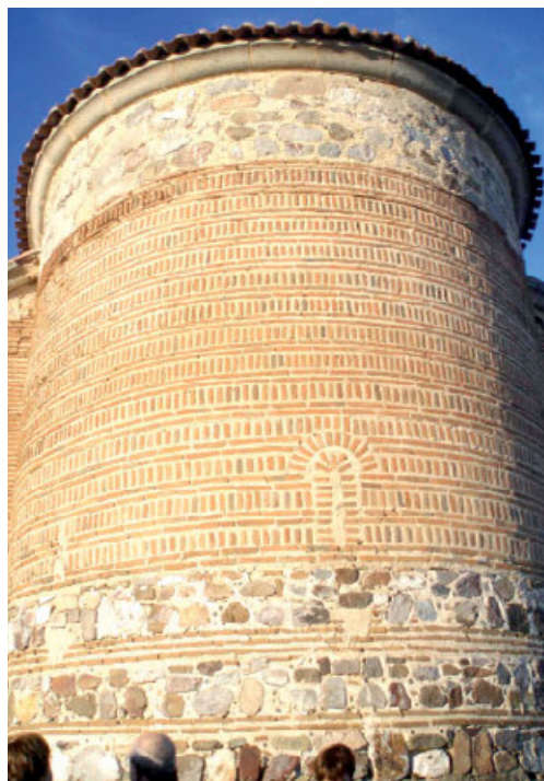
Ábside con ladrillos a sardinel en la Vega de Santa María
