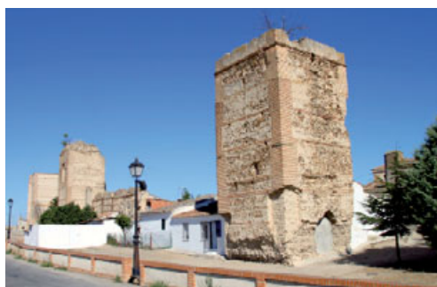
Madrigal de las Altas Torres. Frente sur de la muralla sur, ante el palacio real
