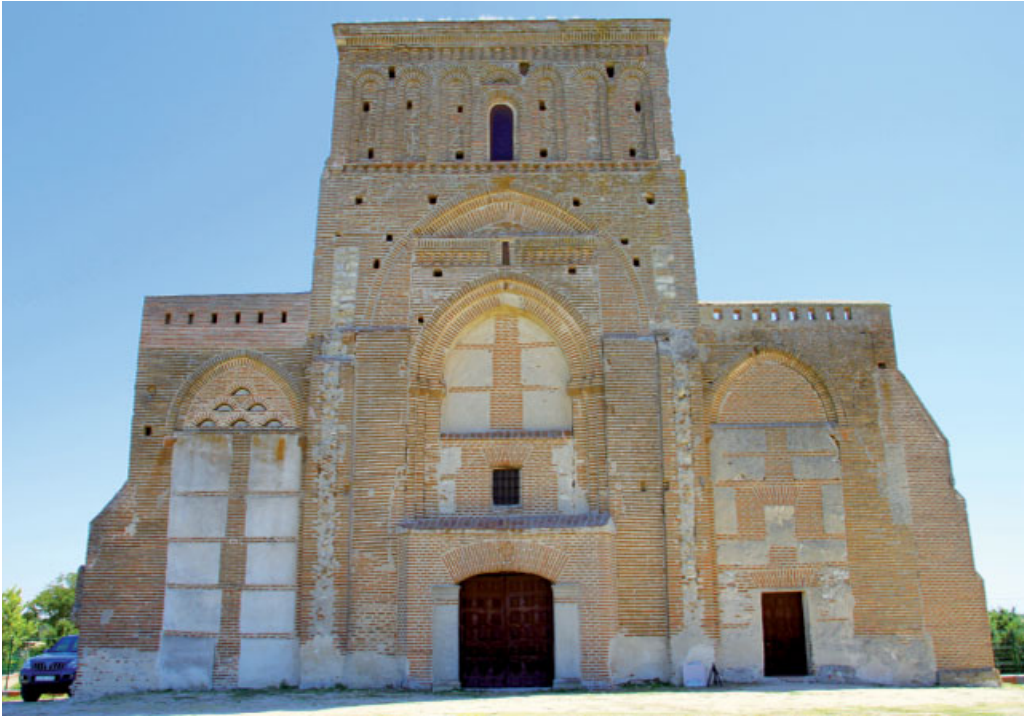
Vista desde el Oeste
