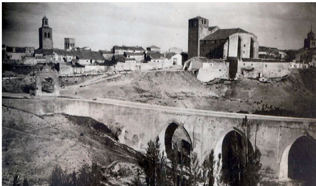
Muralla de Arévalo. Puente de Medina y muros del Arevalillo antes de la restauración de Gabriel Alomar de 1968
