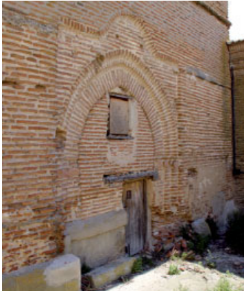
Nuevo acceso a la torre tras ser forrada
