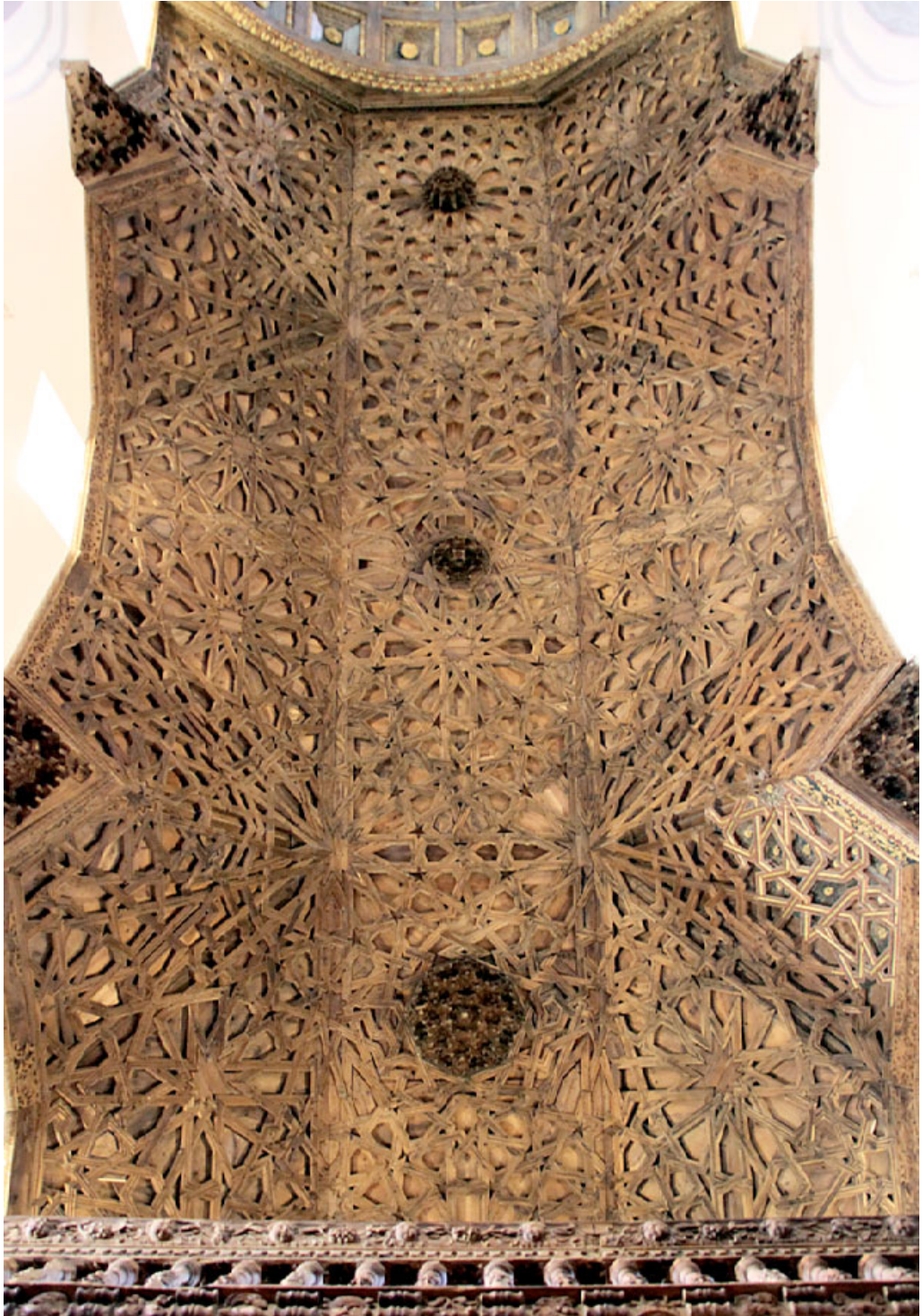
San Nicolás de Madrigal. Armadura de la nave central
