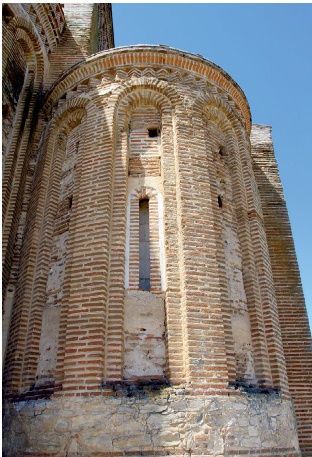
Ábside lateral norte
