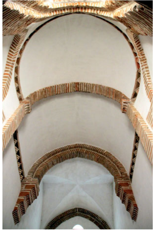
Ábside Norte. Planta de herradura, abovedamiento y mensulones
