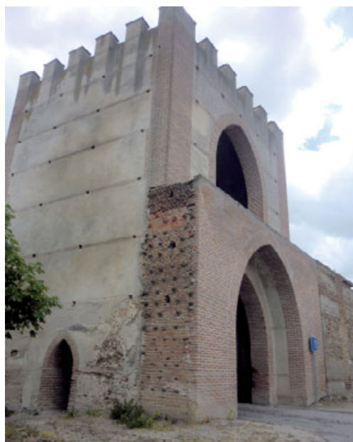
Madrigal de las Altas Torres. Puerta de Arévalo, «barbacana» y lienzo tras su «reconstrucción»
