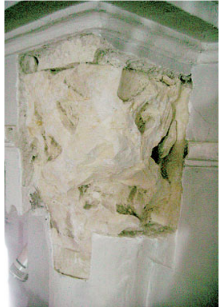
Cata. Capitel arco toral. Castela Restauraciones
