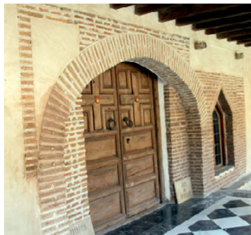
Castillo de Narros de Saldueña. Puertas y ventanas reformadas
