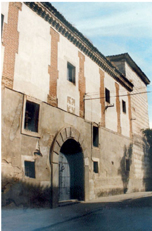
Palacio real de Arévalo. Fachada conventual a la calle Real
