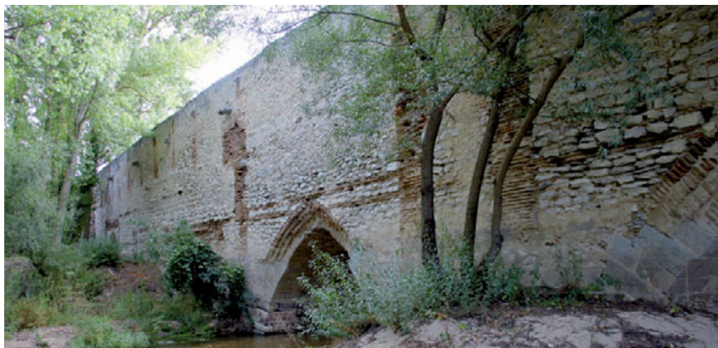
Arévalo. Puente de Valladolid
