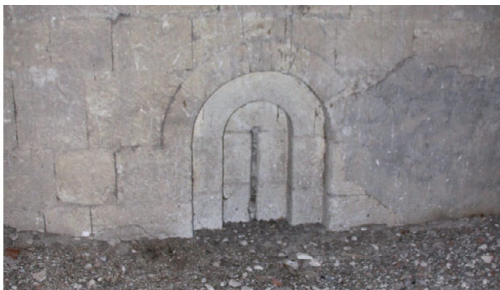
Ventana norte del tramo recto
