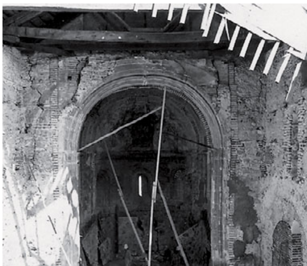
Interior tras el derribo
