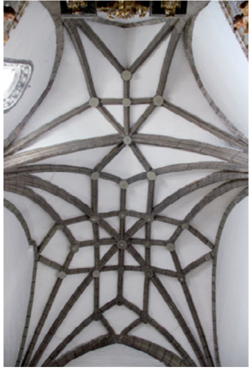
Bóvedas de la capilla mayor
