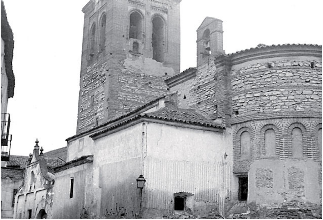
Santa María de Arévalo antes de la demolición de las capillas laterales
