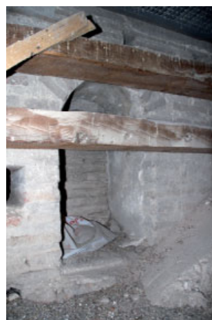
Ventana original de la nave central hoy cegada
