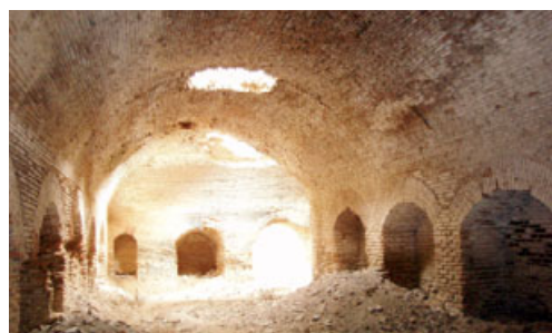
Castillo de Castronuevo en Rivilla de Barajas. Sótanos de la barrera
