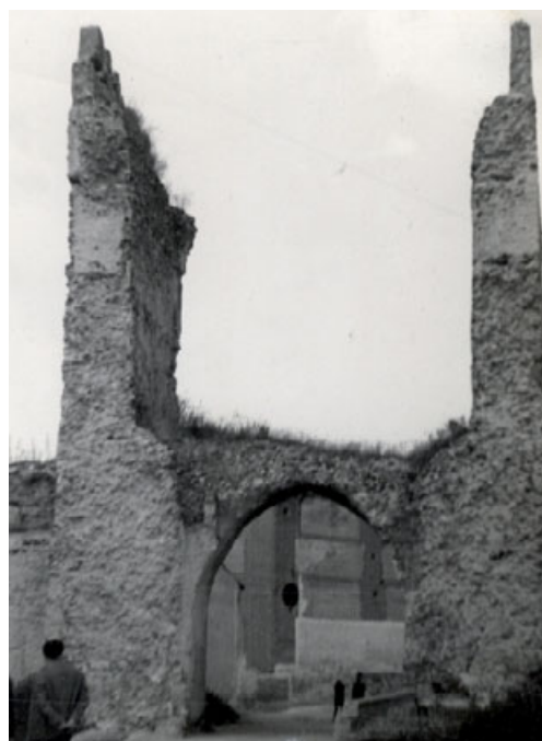
Madrigal de las Altas Torres. Puerta de Arévalo en 1962, tras su derrumbamiento. AGA 65-184
