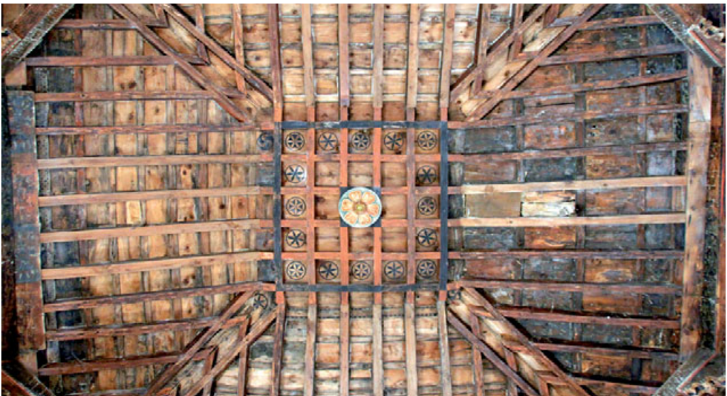
Armadura de la cabecera
