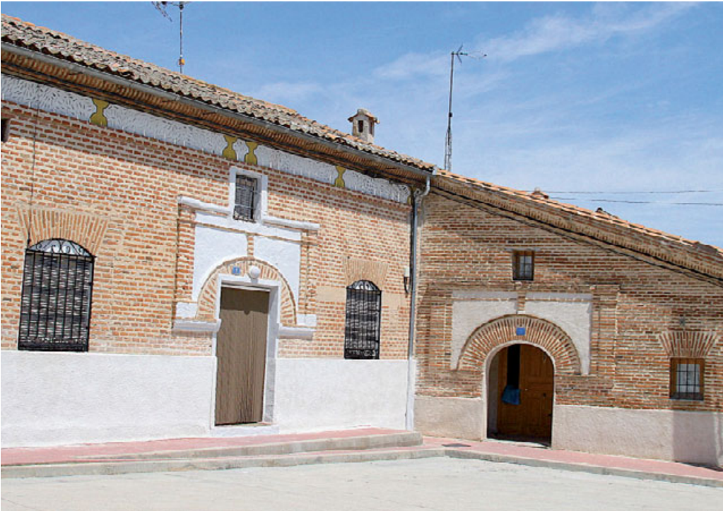
Adanero. Portadas características con rosca de ladrillos convergentes con chambrana, recogidas por alfiz
