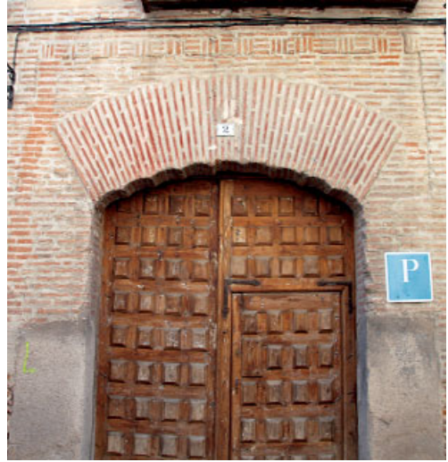
Arévalo. Palacio de ValdeágUILA. Puerta
