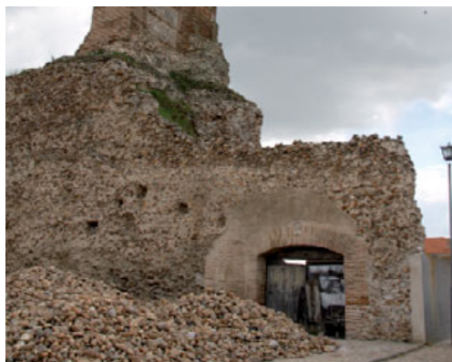
Madrigal de las Altas Torres. Puerta de Peñaranda, arco reconstruido. 2011
