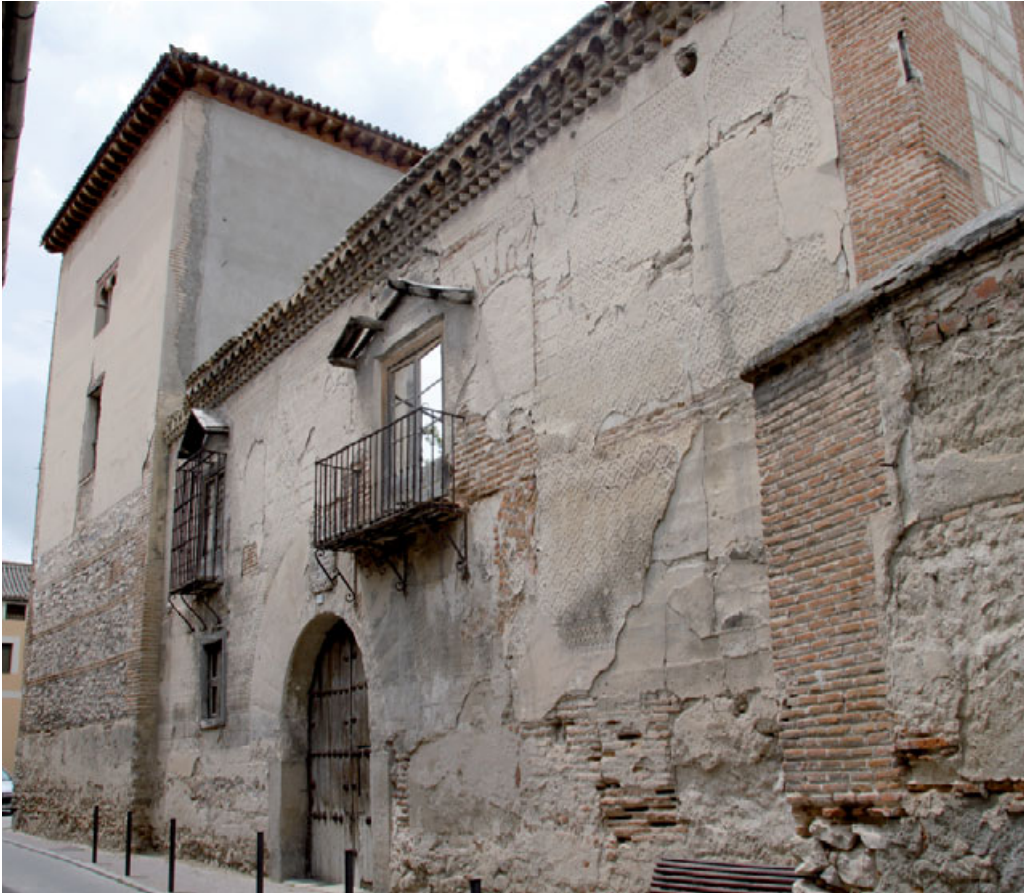
Arévalo. Palacio de los Sedeño. Fachada y torre. Estado actual
