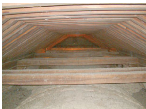
Armadura entre la cubierta y las yeserías en Fuente el Sáuz. Detalle
