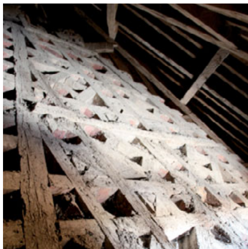
Trasdós de la armadura del presbiterio del Hospital real de Madrigal
