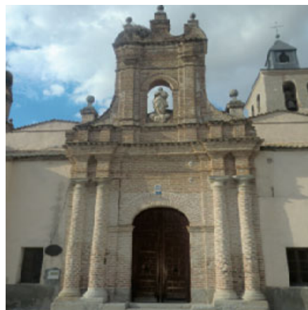
Puerta meridional de la iglesia de Adanero
