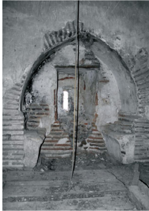
Interior de la torre occidental. Balcón de asiento
