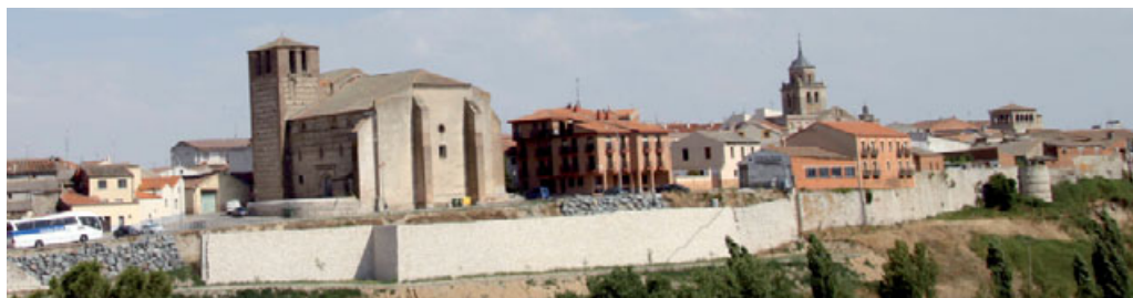
Muralla de Arévalo en la zona del Arevalillo durante la restauración de Francisco Jurado de 2011
