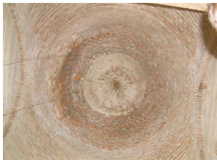
Fuentes de Año. Pechinas y arranque de la cúpula. Fot. I. Hernández G. de la Barrera
