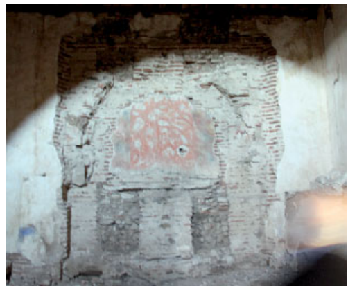
Hueco del arcosolio en la capilla de Pedro Sánchez
