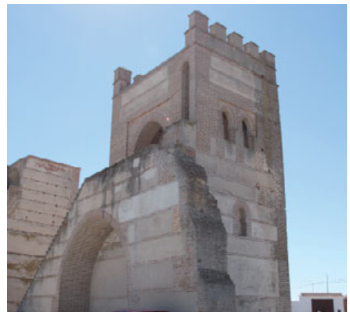
Madrigal. Torre del castillo de San Hilario restaurada con el arco tómico inferior inventado
