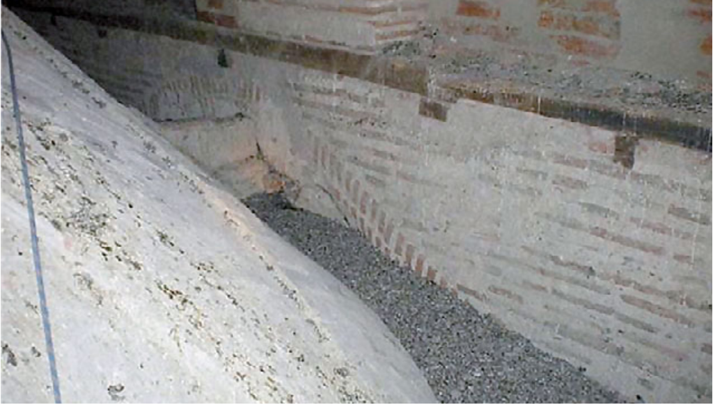
Bajocubierta, arco toral del crucero original. Foto I. Hernández García de la Barrera
