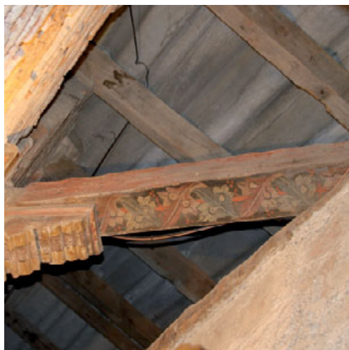
Cuadral de la armadura de la cruja sur del presbiterio del hospital real de Madrigal
