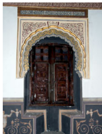
Madrigal. Decorado de embocaduras de ventana en sala de la torre oeste del palacio real
