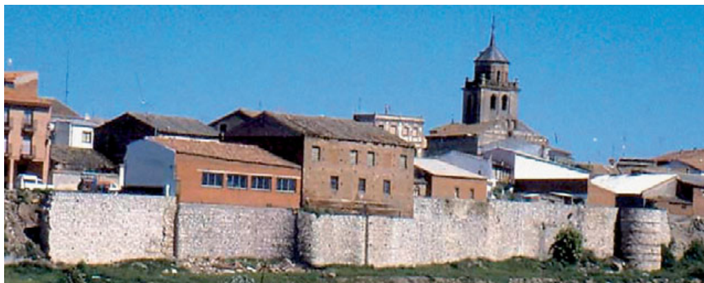
Muralla de Arévalo en la zona del Arevalillo tras la restauración de Gabriel Alomar de 1968
