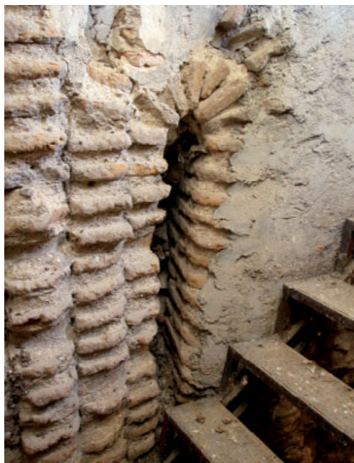
Vano en el primer cuerpo de la torre
