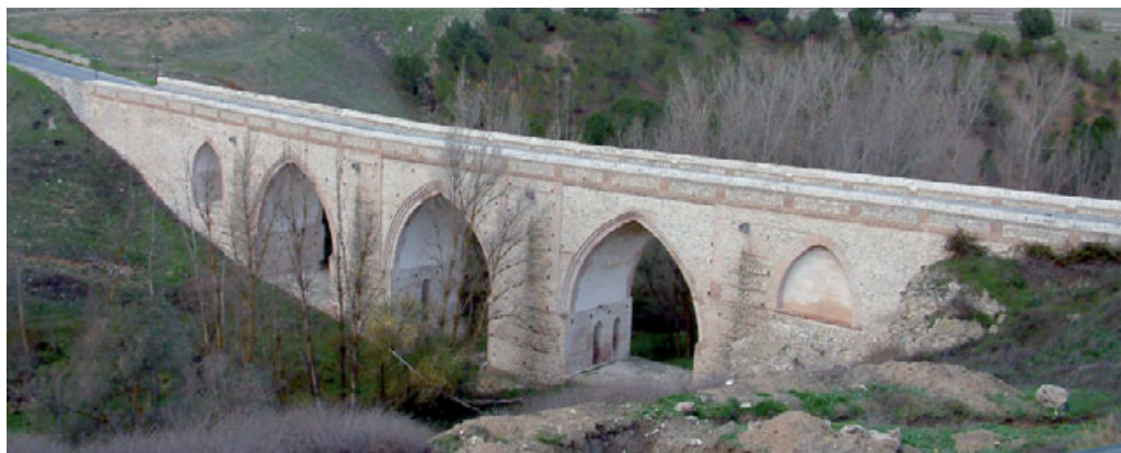
Arévalo. Puente de Medina
