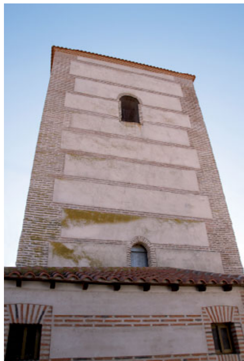
Torre tras la reforma
