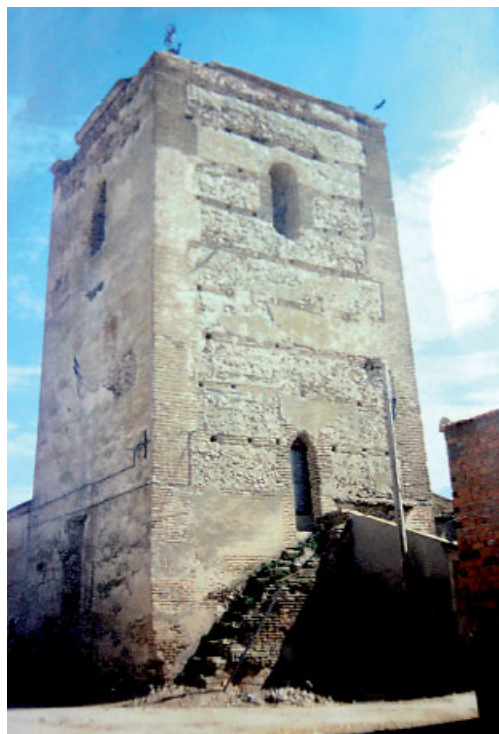
Torre antes de la reforma
