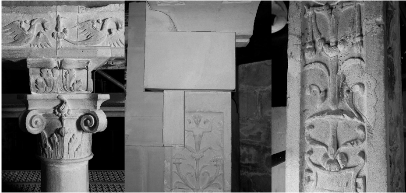
Fig. 3. Injerto de piedra tallada, injerto de piedra sin tallar y reconstrucción con mortero. © Pere Terrasa.
