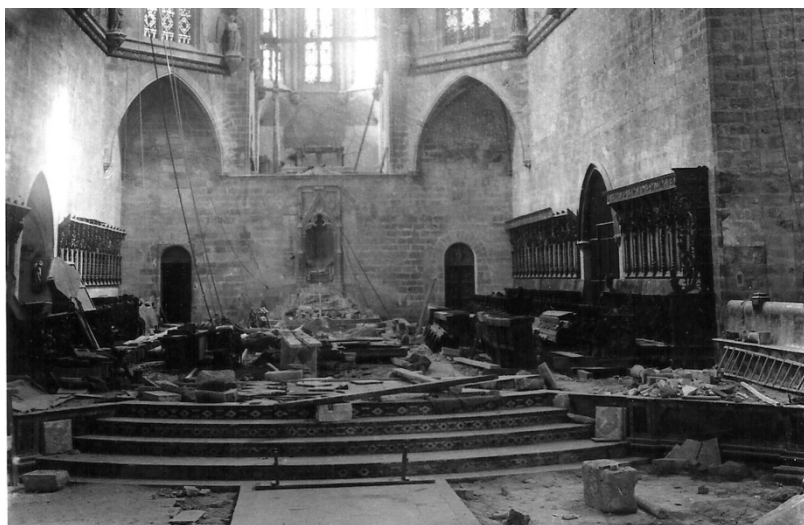
Fig. 4. Colocación de la sillería del coro en la capilla mayor de la catedral de Mallorca, 1904. Foto Emili Sagristá (Archivo Capitular de Mallorca).
