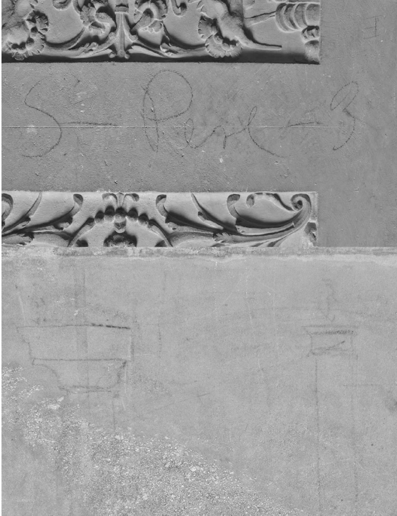
Fig. 2. Anotaciones de ubicación y de resolución de problemas constructivos realizadas por Gaudí y/o su equipo. © Pere Terrasa.
